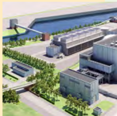
Am STEAG-Kraftwerksstandort Herne wird ein hocheffizientes Gas- und Dampfturbinenkraftwerk gebaut.
