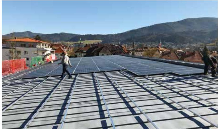
Montage der leichten eArc-Solarmodule auf dem Dach der Stadthalle.
