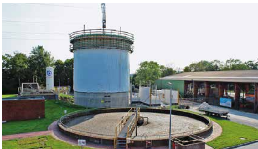
Der neue Faulturm der Stadtwerke Leer entsteht: Die Kosten behielt der Versorger dank California.pro stets im Blick.
