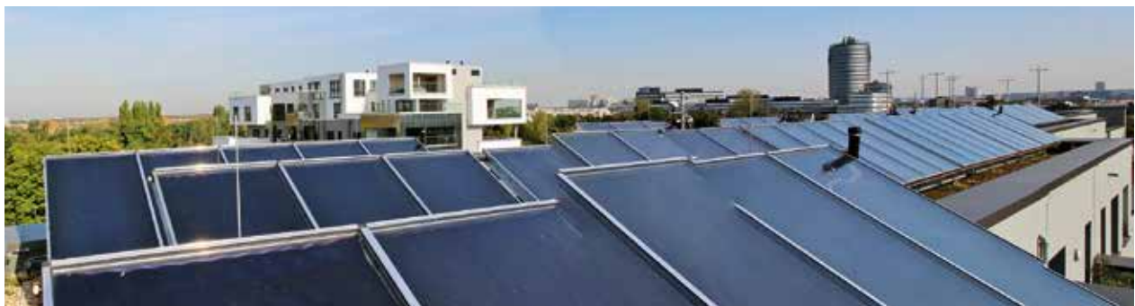
Kollektorfeld der Düsseldorfer Versuchsanlage im Forschungsvorhaben SWD.SOL II.
