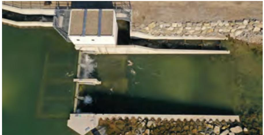
*Schachtkraftwerk: Fische wandern durch die Aussparung im Wehr flussabwärts.*
