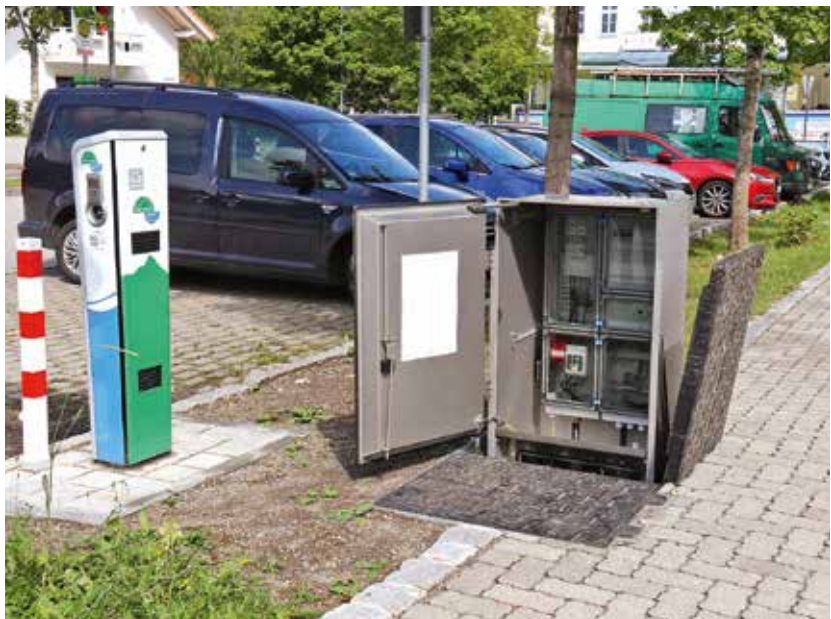
Langmatz-Lösung für Ladesäulen: Unterflurverteiler mit Netzanschluss.
