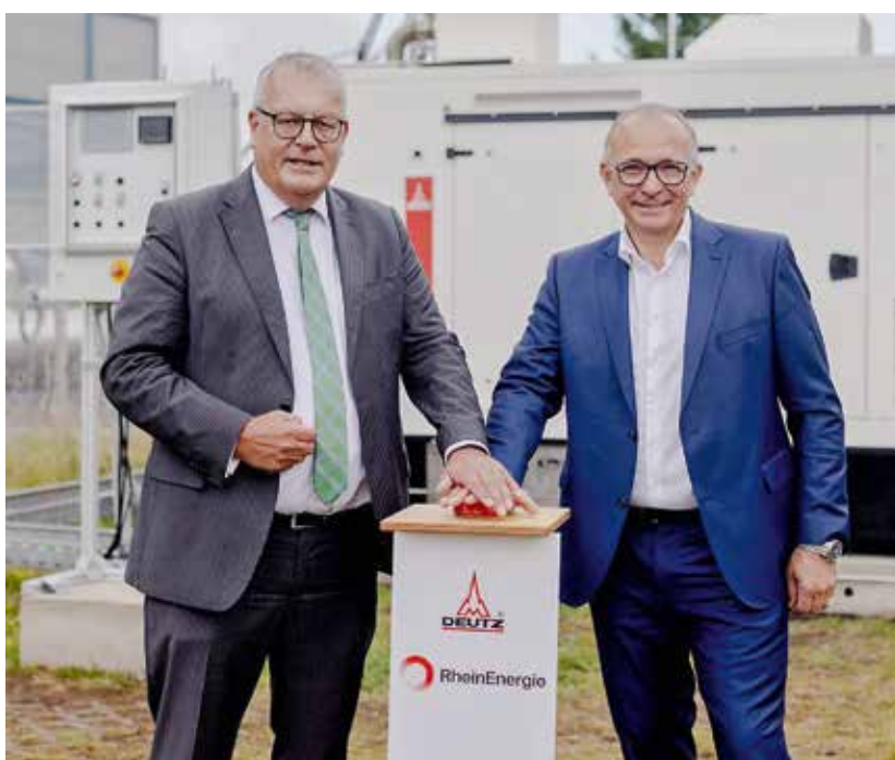
Start des Wasserstoffmotors am RheinEnergie-Heizkraftwerk Niehl.*
