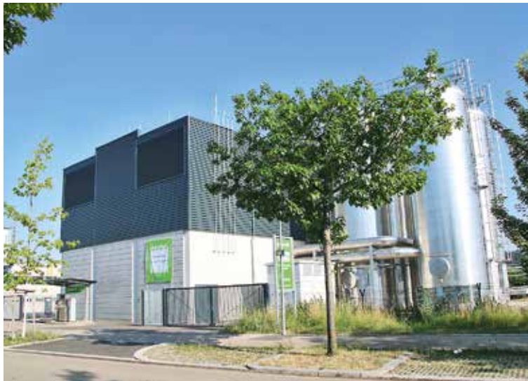
Kraftwerk Hessental der Stadtwerke Schwäbisch Hall.
