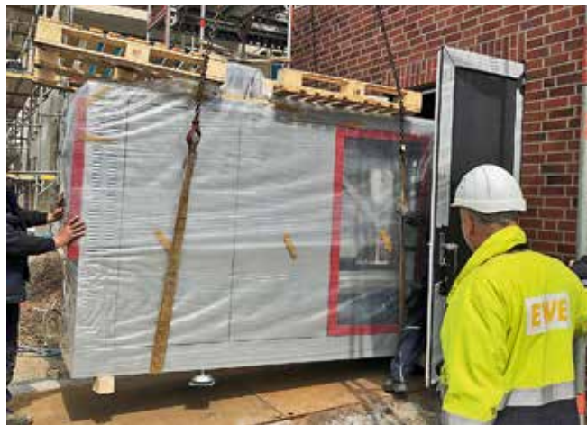
Einbringung des ersten BHKW-Moduls in der Energiezentrale.
