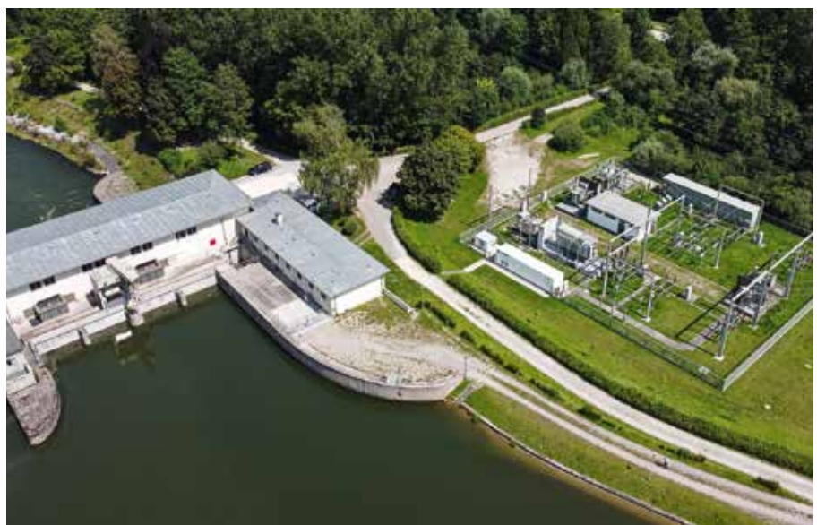
Am Unteren Lech wird mit Wasserkraft Primärregelenergie erzeugt.
